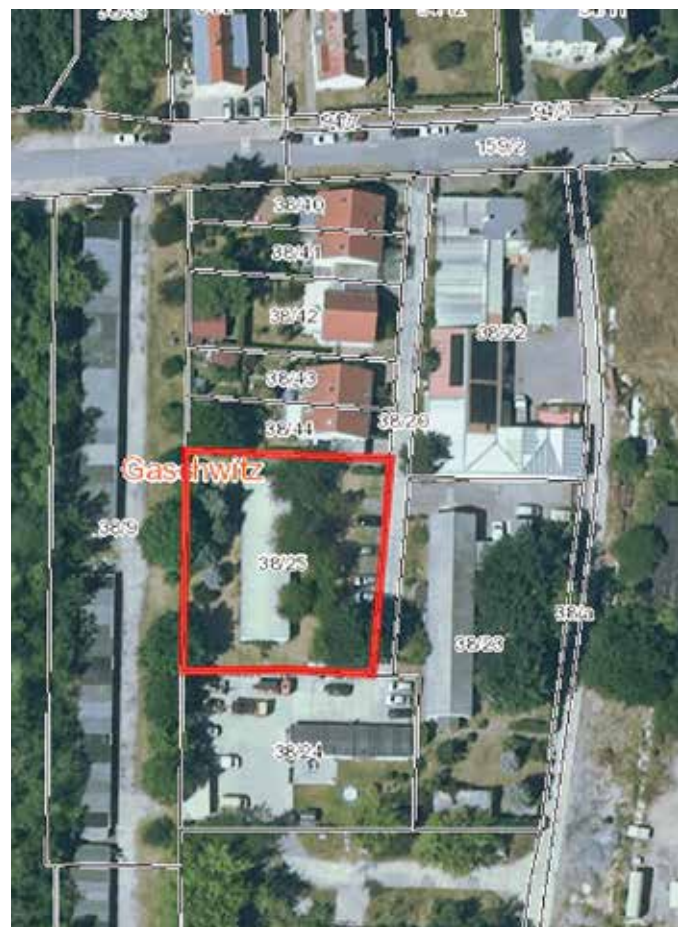
Lage des ehemaligen Schützenhauses in Gaschwitz.
